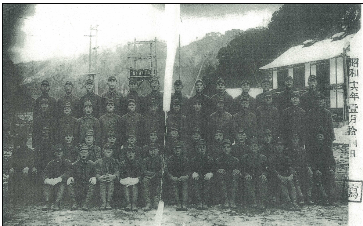
北原発電所建設現場で写した朝鮮人青年ら？
